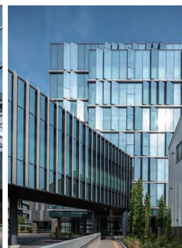
渡り廊下外観
