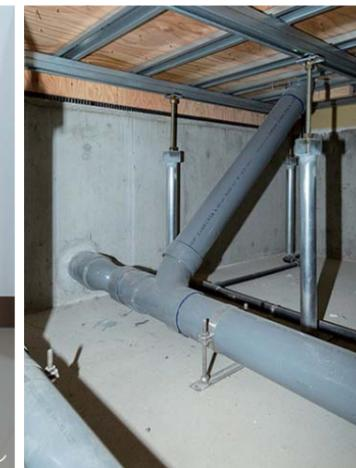
インテリアに調和した木製のトイレサイン。災害時でも普段通りトイレが使えるように平常時5L/断水時1Lで使用するレジリエンス レジリエンストイレが規定する排水配管。ビクトグラムでわかりやすく表示している。トイレを男女共用トイレと多機能トイレに採用。多機能トイレにはシャワートイレも採用。45°エルボと大曲りY字管の2つの継手で施工。
