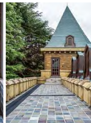
南面屋上全景
