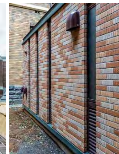
新設:トイレ外壁面
