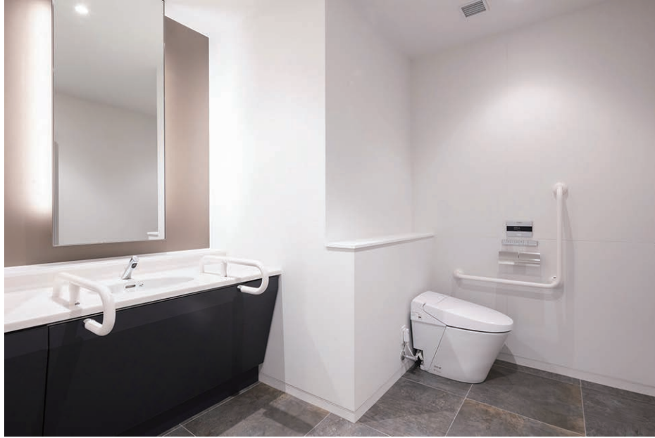
2F VIPルームトイレ 洗面・大便器
