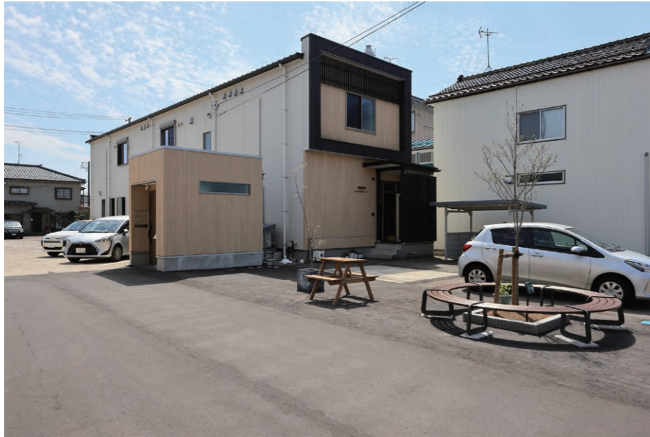
駐車場からもアクセス可能。軒下は雨天時に傘の開閉が出来る奥行を確保
